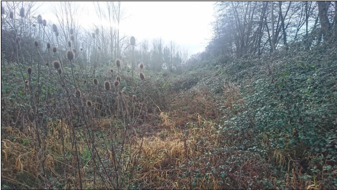
Partie basse et levée de berge sur ruisseau (avant défrichage)
